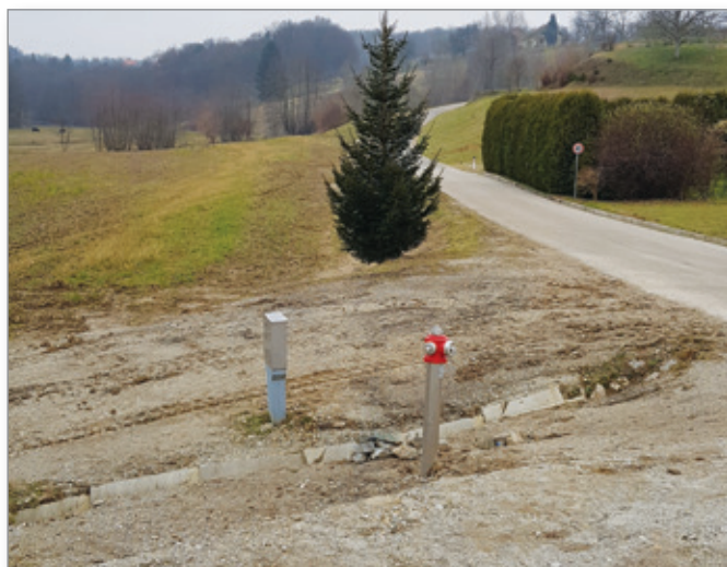
Izgradnja vodovoda v naselju Brengova
